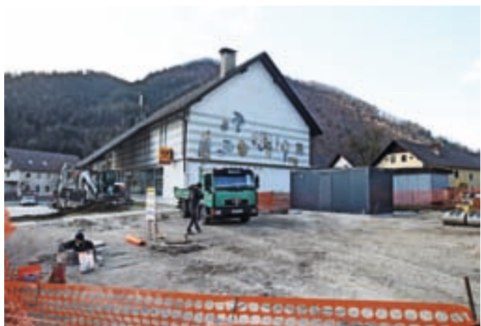
Gradnja tržnice naj bi bila končana do konca aprila. / Foto: Gorazd Kavčič
